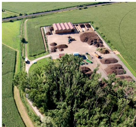
Photo 1 : Vue générale d'une compostière
